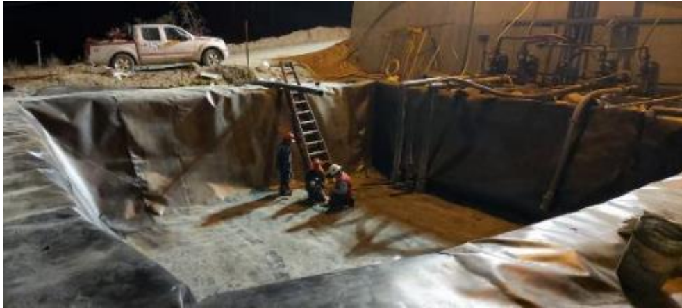
Trabajo de revestimiento y soldaduras verticales terminadas
