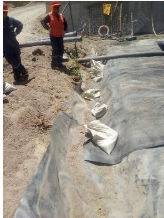
Detalles de apoyo de despliegue y apoyo con sacos con arena
