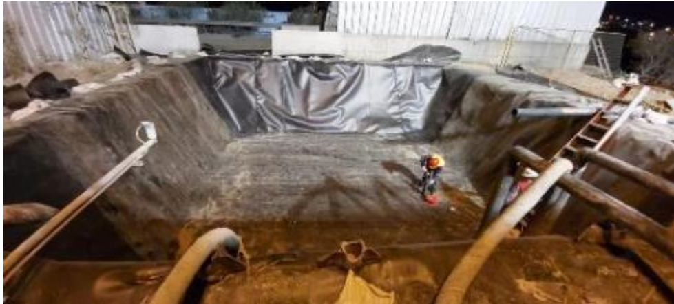
Piscina agua de proceso terminada de revestir
