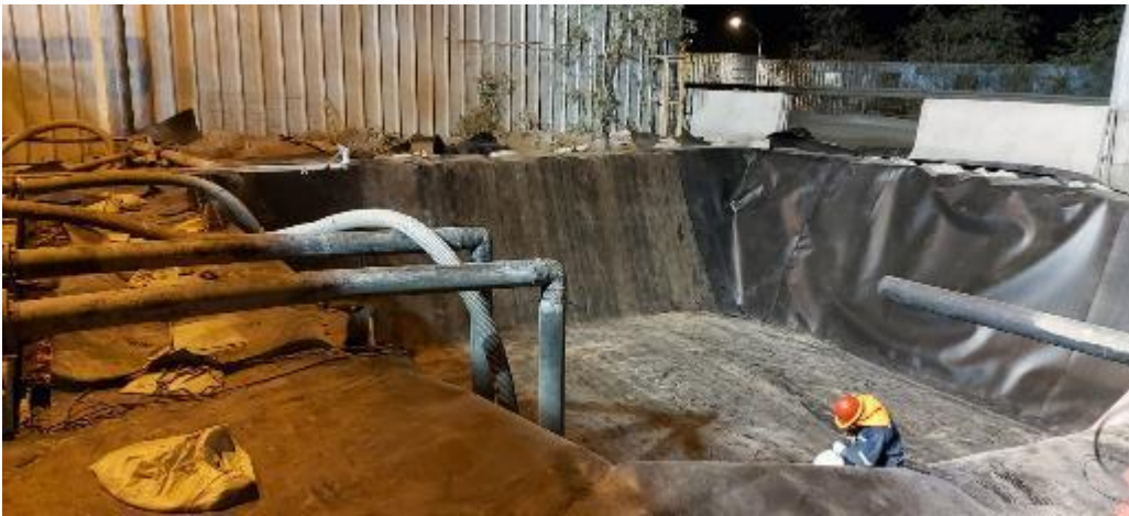
Otra vista de trabajo de revestimiento y soldaduras verticales terminadas
