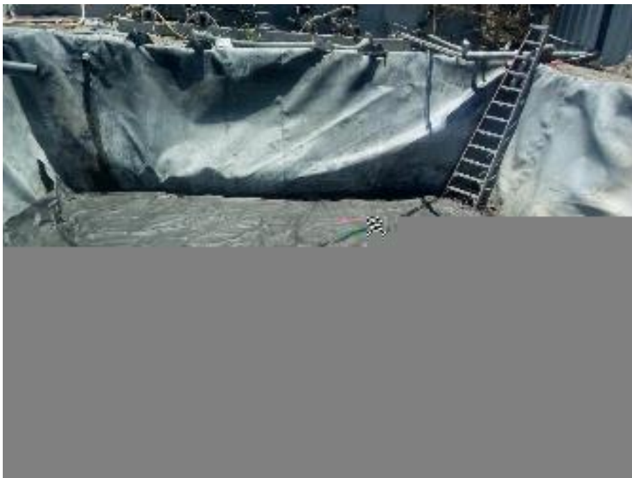
Pozo con Geotextil sobre fondo cubierto con arena
