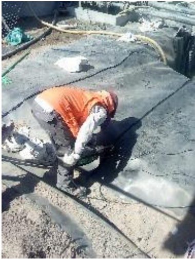
Aplicación de cordón por extrusión en parche superior, fuera del nivel de llenado
