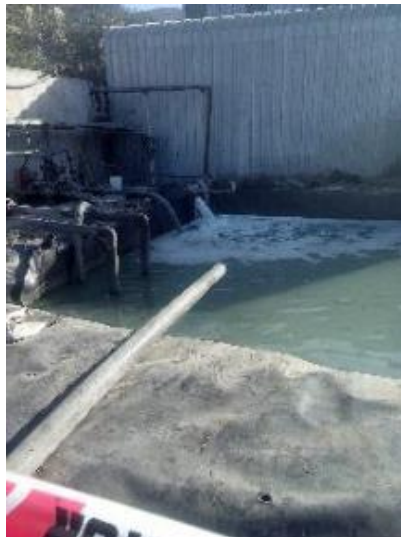
Puesta en servicio de piscina agua de proceso y prueba de impermeabilización, sin evidencia de filtraciones
