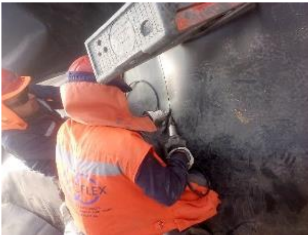
Termofusionado con soplador de aire previo a la extrusión
