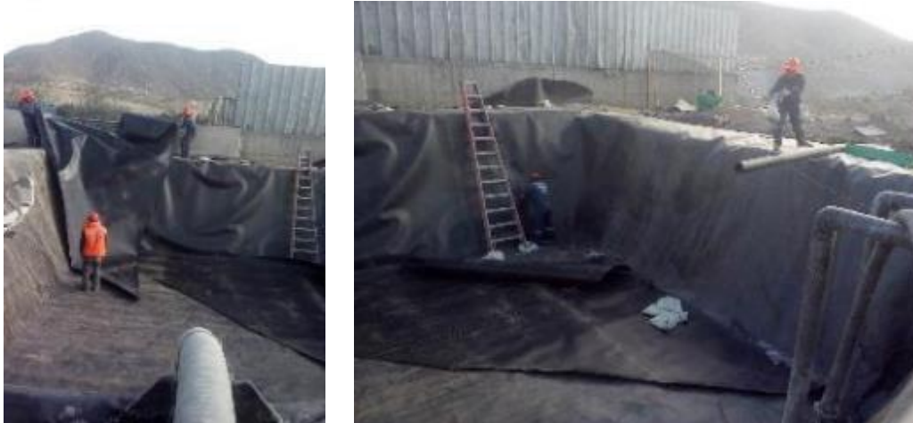
Despliegue de membrana en esquinas
