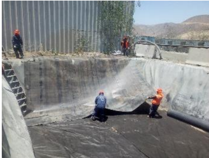
Despliegue de membrana que cubre de lado a lado en un solo paño
