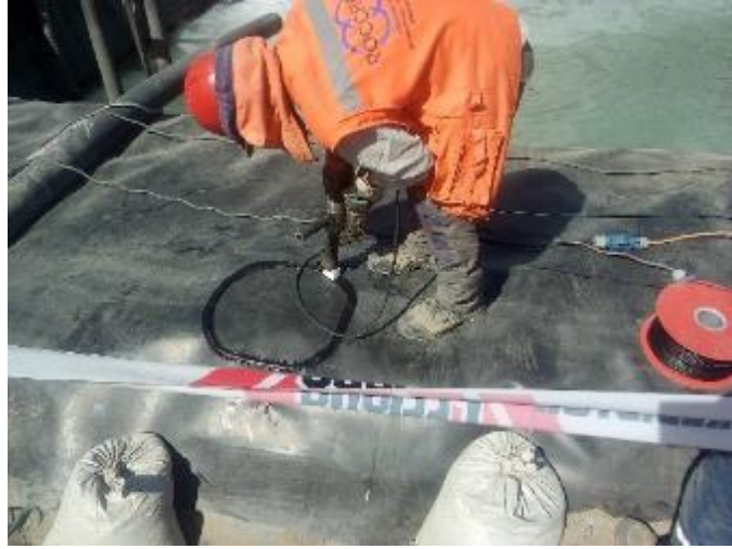
Aplicación de cordón por extrusión en parche superior, fuera del nivel de llenado
