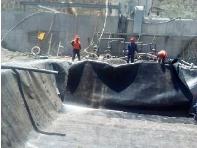
Despliegue de paños de membrana en taludes laterales
