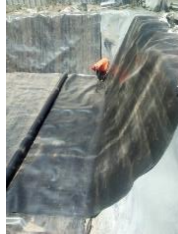
Despliegue de paños de membrana en taludes laterales
