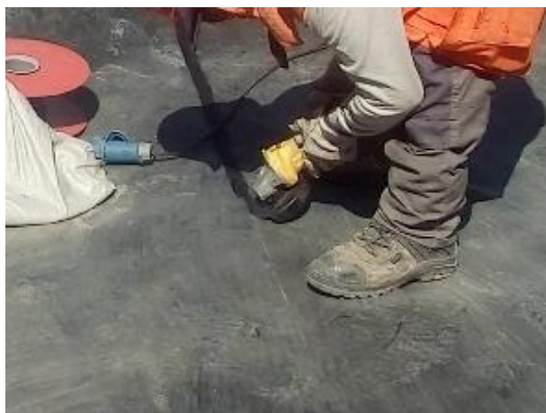
Esmerilado previo a la extrusión
